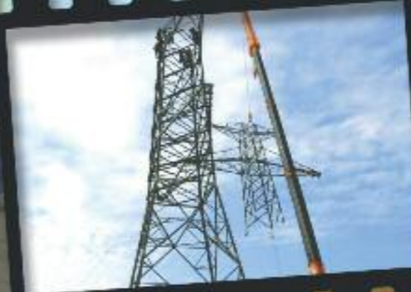
9. Pécs-országhatár 400 kV-os távvezeték építése (52. számú feszítőoszlop) – 2009. október 7.
