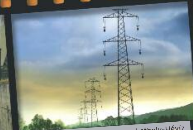
12. Véghajrában a Szombathely-Hévíz 400 kV-os távvezeték építése – 2009. november 11.
